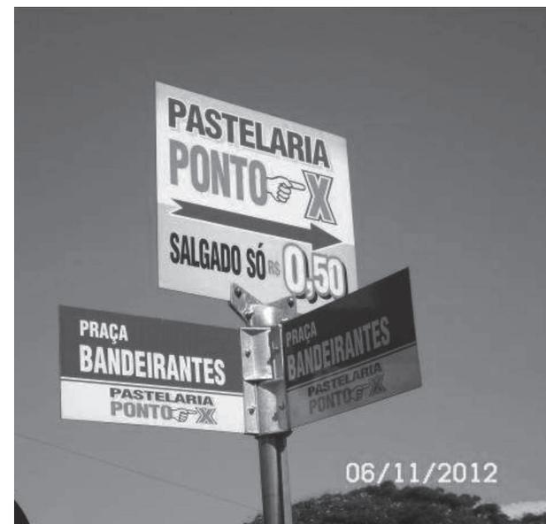
Os postes zincados terão 3,00 metros de altura mínima livre, sendo 0,60m enterrado na calçada, diâmetro mínimo de 75,0 mm, espessura mínima da parede do cano de 2,0 mm. O sistema de fixação das placas deverá ser confeccionado com alumínio reciclado. Abrigos para usuários de ônibus Os abrigos para usuários de ônibus deverão ser predominantemente metálicos, com placas de policarbonato, devendo ser utilizados um dos modelos abaixo, que atendem às necessidades de implantação, de uso e de manutenção.
