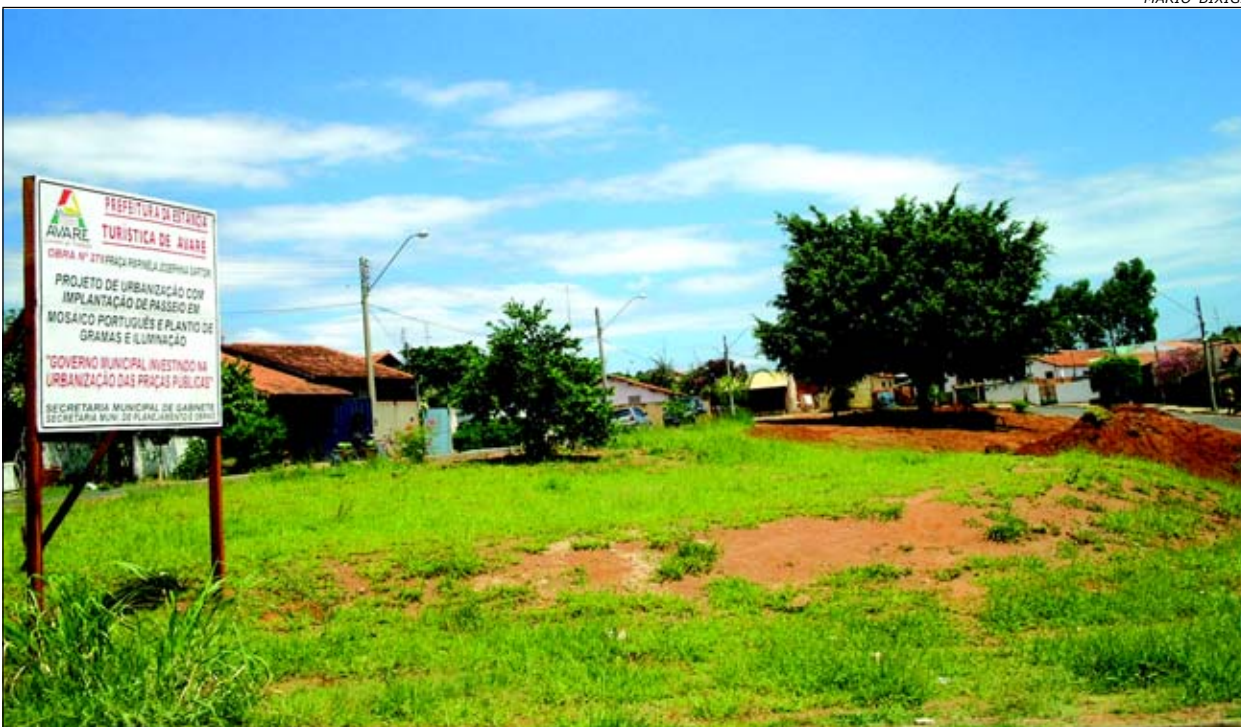
Local está recebendo terraplanagem
