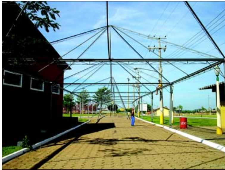
Recinto está recebendo uma grande estrutura
