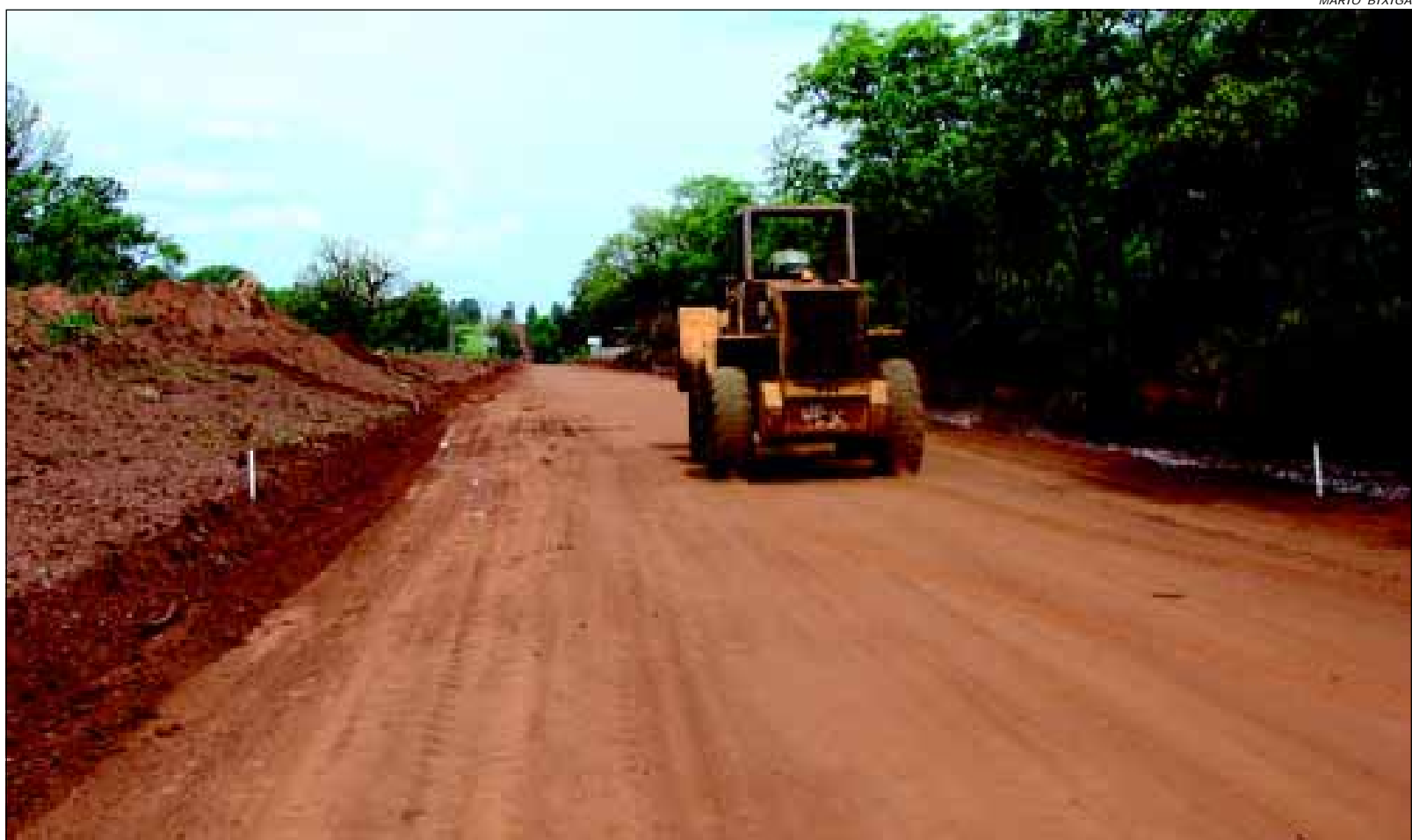
Nos próximos dias a Avenida Copacabana já estará pronta para receber o asfalto
