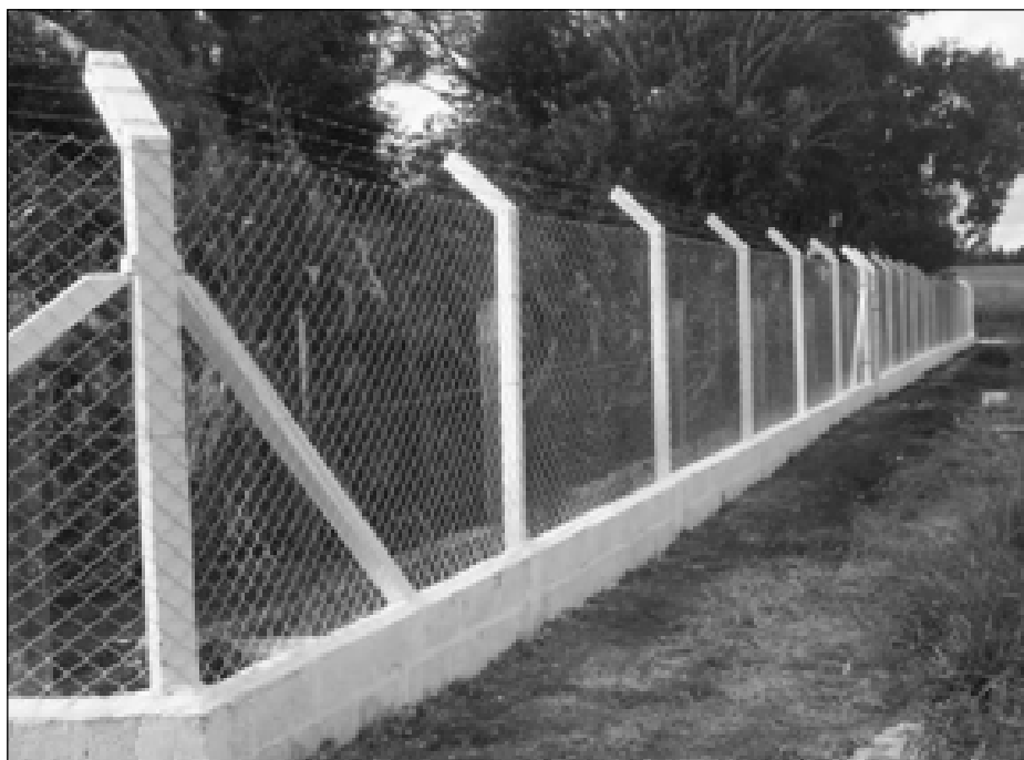
Terreno do futuro prédio da Câmara foi fechado com alambrado
