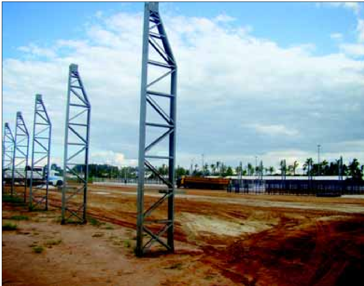
Obras da cobertura da Pista de Velocidade
