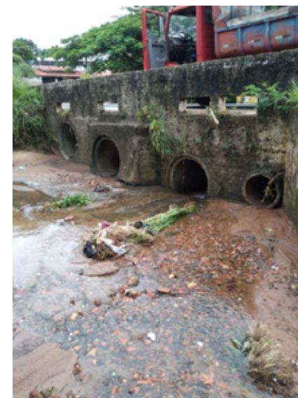
LIMPEZA DE BUEIRO JARDIM BRASIL
