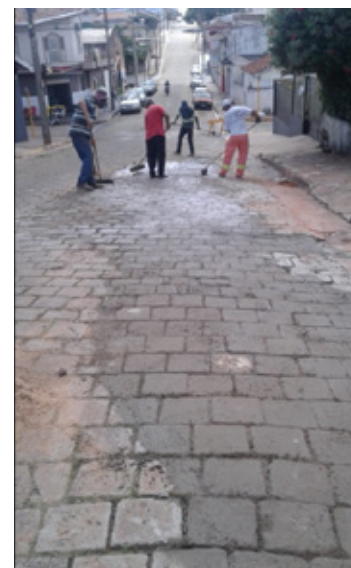
CALÇAMENTO RUA LINEU PRESTES
