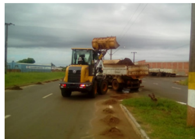
LIMPEZA - AV. CUNHA BUENO
