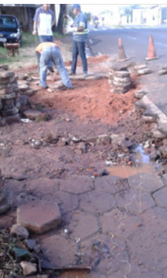
CALÇAMENTO AV. GILBERTO FIGUEIRAS
