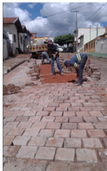
CALÇAMENTO RUA BASTOS CRUZ
