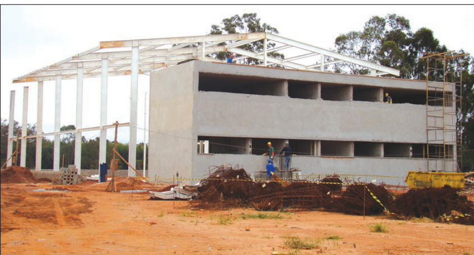
Construção da quadra poliesportiva da escola
