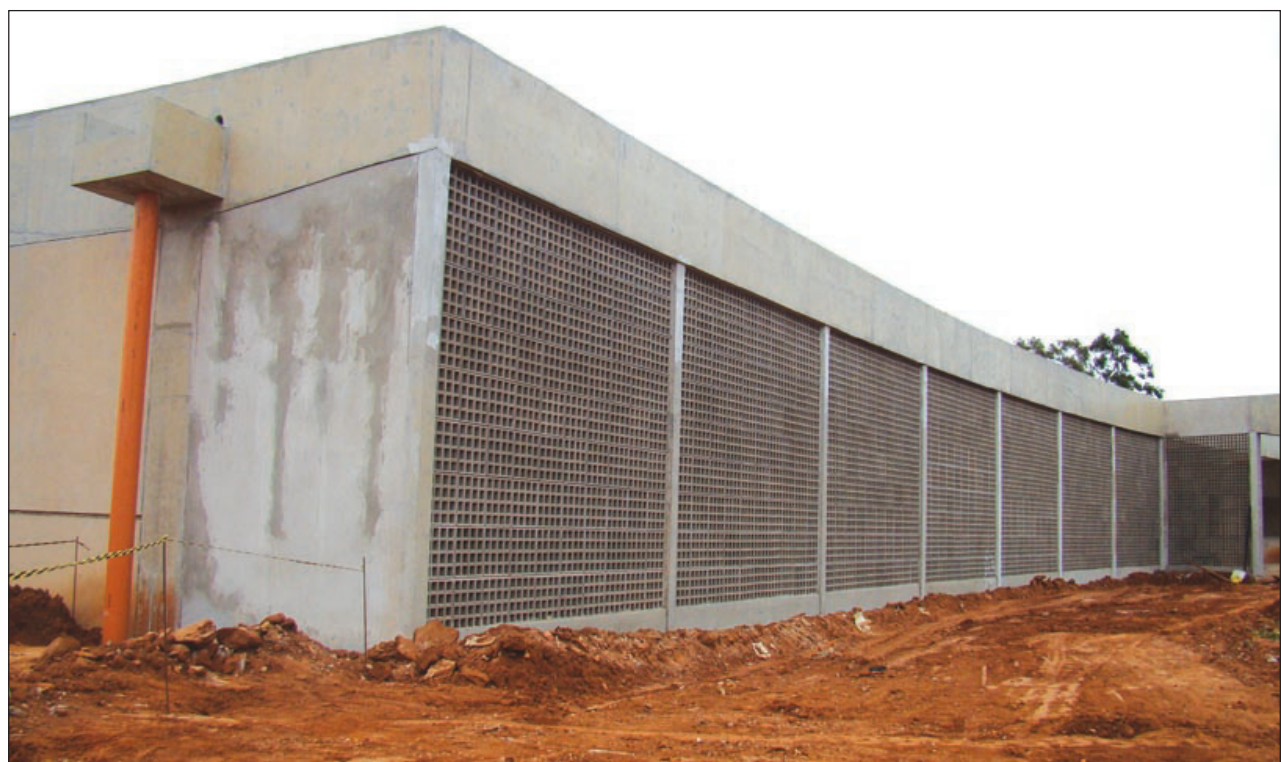
Futuras instalações da Escola do SESI
