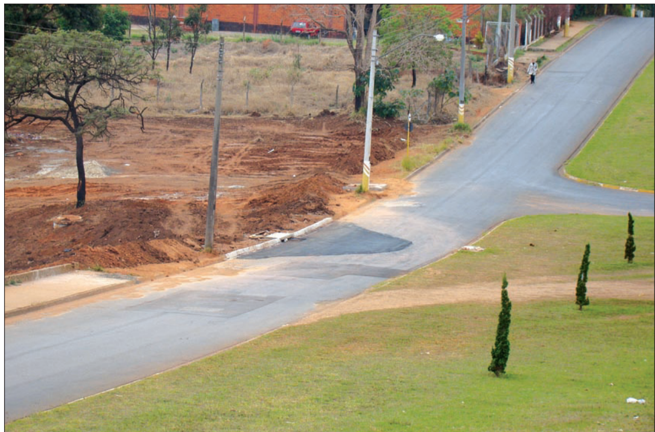
Obra da Avenida Espanha foi finalizada
