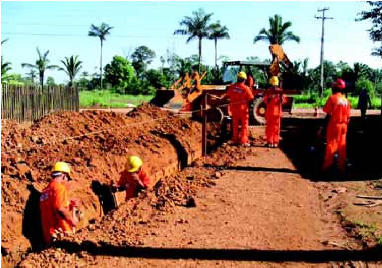
Entre as benfeitorias a serem realizadas no distrito industrial, está prevista a implantação da rede de esgotos conforme foto ilustrativa.
