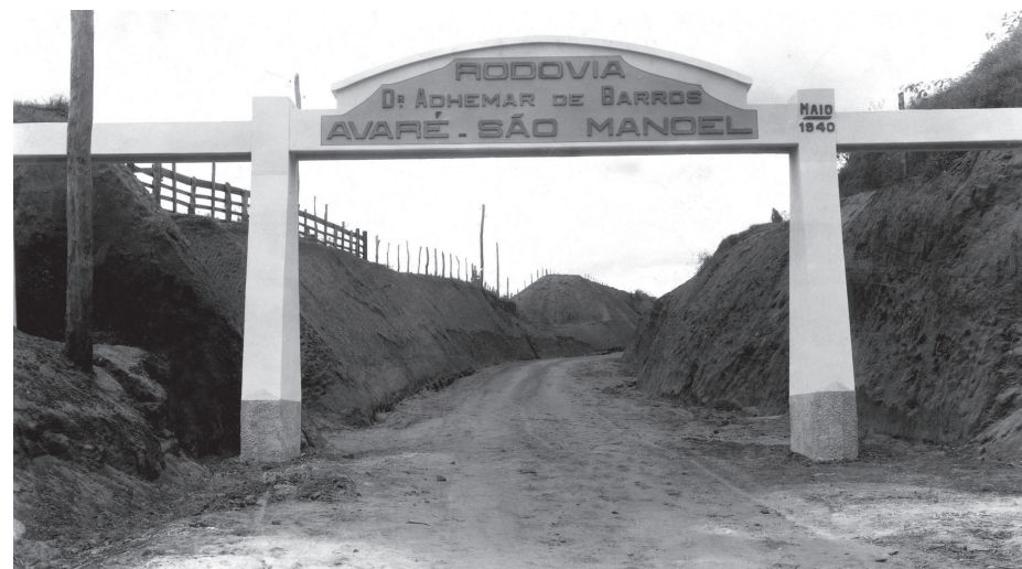
Portal da Rodovia Adhemar de Barros, início da estrada Avaré-São Manuel
