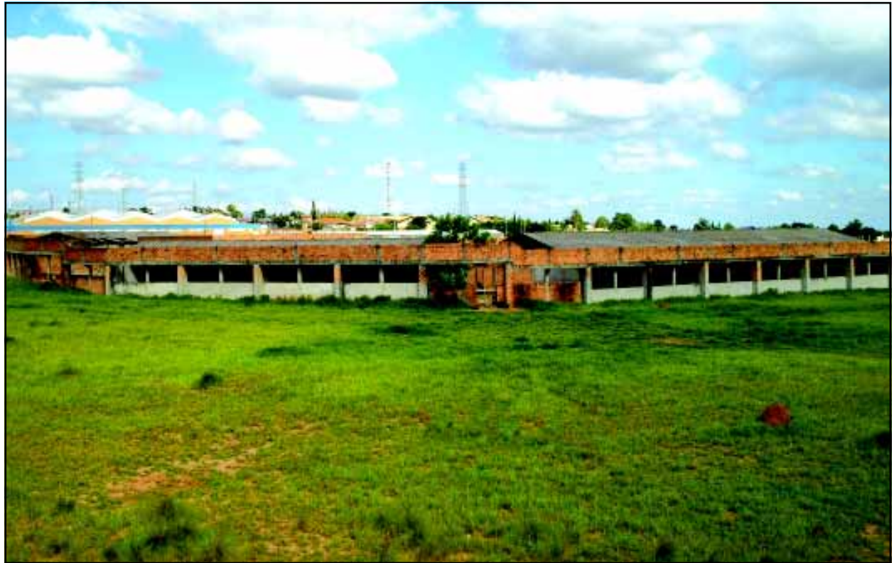
A unidade será construída na Avenida Professor Celso Ferreira da Silva
