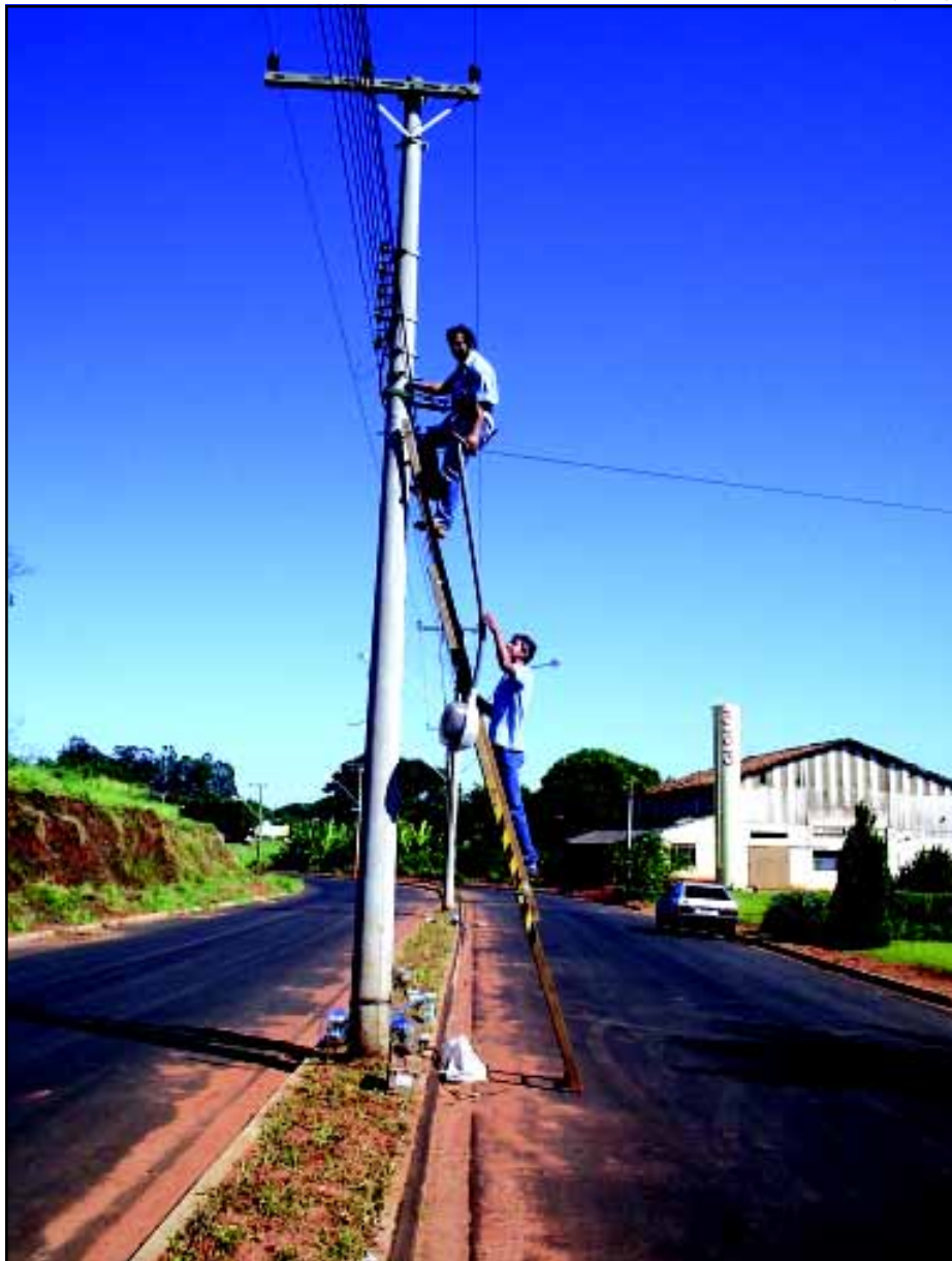
Estão sendo instaladas luminárias de vapor de sódio de 250 watts
