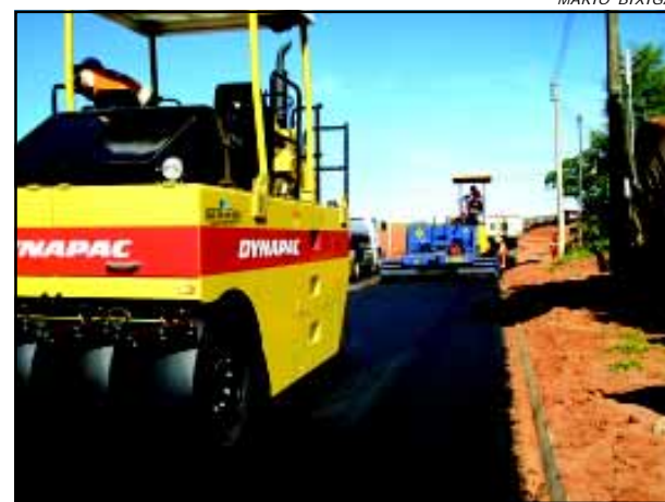
Pavimentação faz parte do projeto de melhoria de acesso aos bairros
