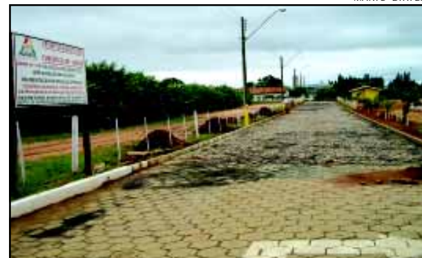
No local foram implantados paralelepípedos que estavam nas ruas do Bairro Alto
