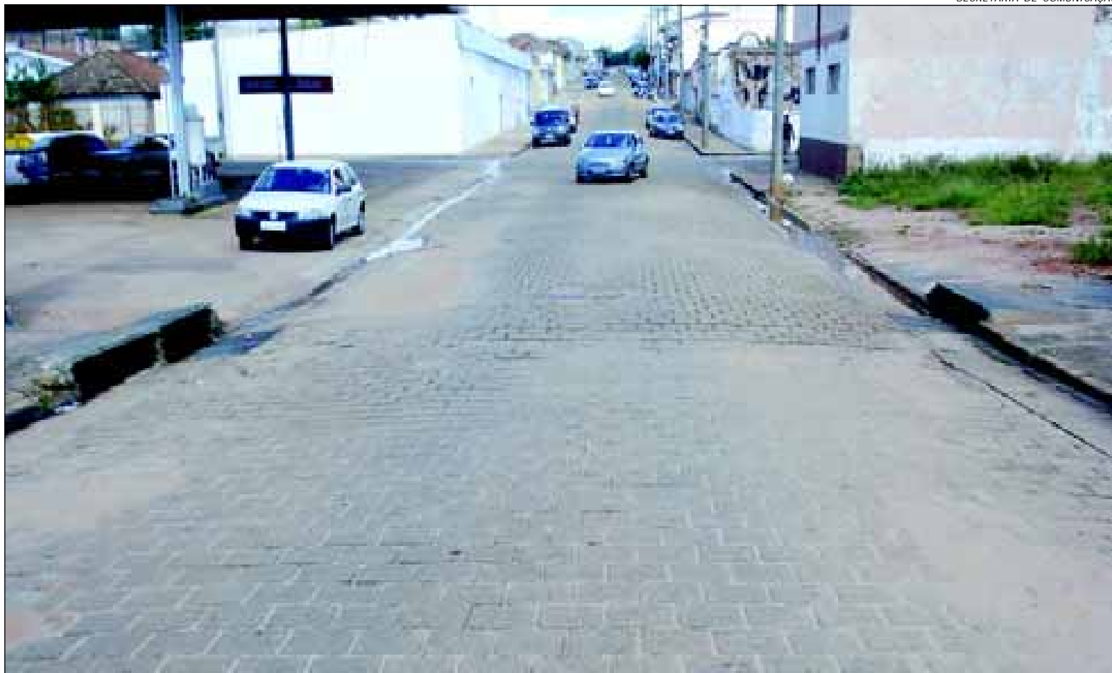
Cruzamento da Rua Distrito Federal com Rua Maranhão, onde será beneficiado com as obras de combate as enchentes
