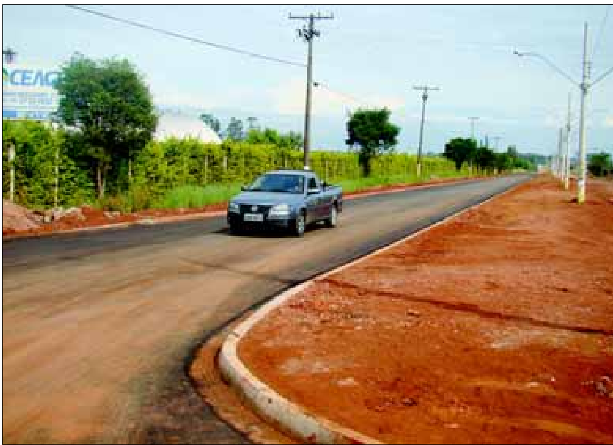
Veículos já estão utilizando a pista asfaltada
