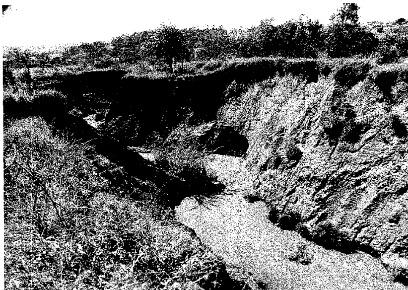
Foto 31: Erosão (ER10) – Parque Ecológico – Av. Espanha (713.127 m E, 7.445.841 m S). Fonte: IPT, 2015.
