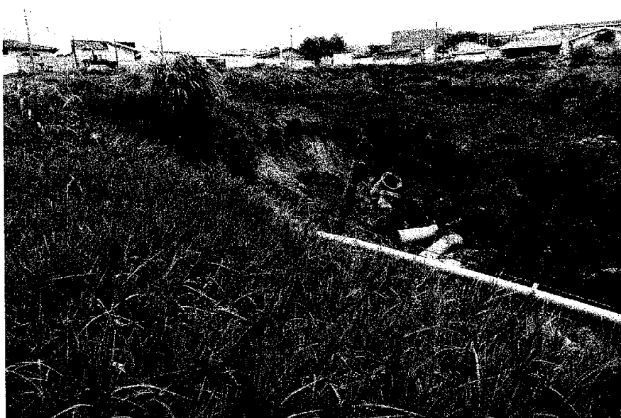
Foto 23: Erosão Ponto (ER02) – rua Roldão Eufrázio Leal (713.199 m E, 7.445.347 m S). Fonte: IPT, 2015.
